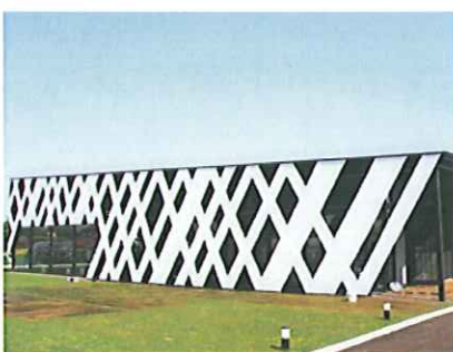
(写真上) ここは斐川平野のど真ん中。島根支社社屋目立ってます！ ~所在地~ 〒699-0555 島根県簸川郡斐川町大字坂田 1934 TEL : 0853-25-7676 FAX : 25-7677 ※朝日新聞島根版で亜矢さんのコラム「いまここ私」好評連載中！
